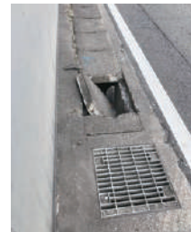
▲側溝の破損
