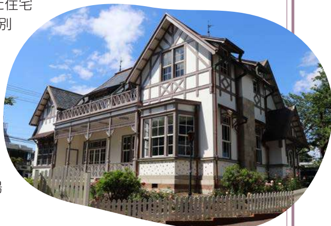
▲重要文化財旧中埜家住宅
