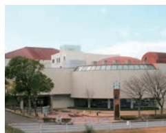
④半田空の科学館・半田市体育館
