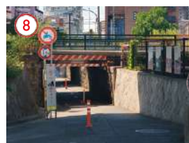
8 頭を打ちそうな高さの高架下
