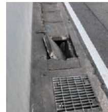
▲側溝の破損
