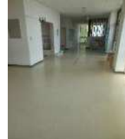
2階トイレ前廊下
