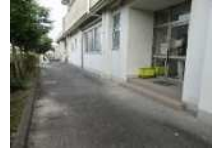
職員玄関周り
