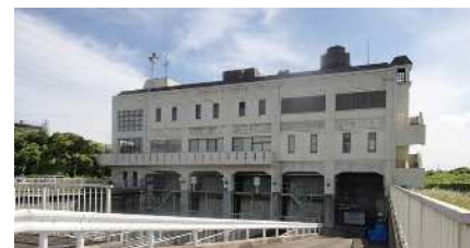
瑞穂排水ポンプ場
