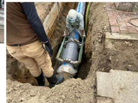
非耐震管から耐震管への布設替（φ300mmの基幹管路）
