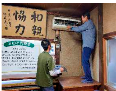
▲エアコンのフィルター清掃
