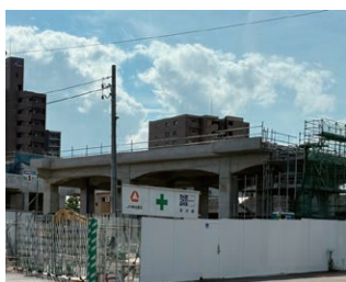
工事中の JR 半田駅
