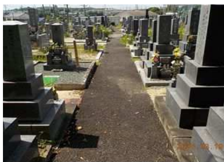
通路整備工事（北部墓地）
