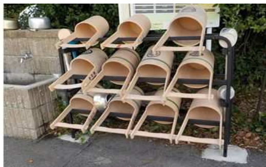
桶置き場整備工事（北谷墓地）
