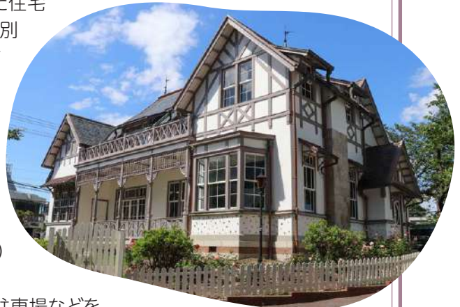
▲重要文化財旧中埜家住宅
