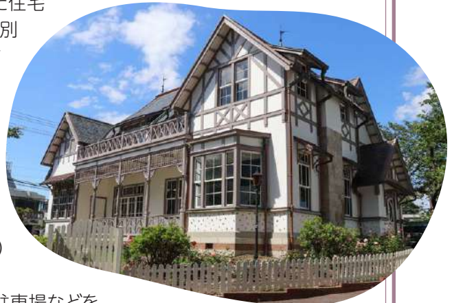
▲重要文化財旧中埜家住宅
