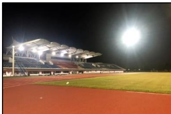
LED化された施設
