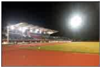
LED化された施設
