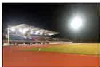
LED化された施設
