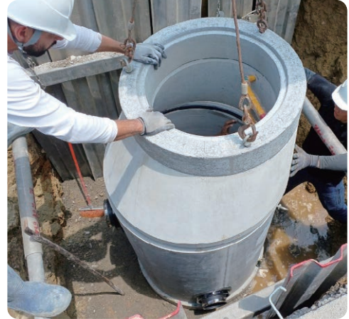
下水道工事の様子
