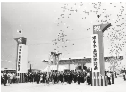
知多半島道路全線開通(昭和46年)
