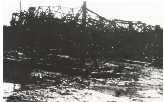
米軍の空爆で破壊された中島飛行機半田製作所本工場 提供: 半田空襲と戦争を記録する会
