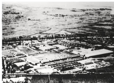
東洋紡績株式会社知多工場 全景
