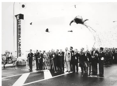
衣浦海底トンネル開通（昭和48年）
