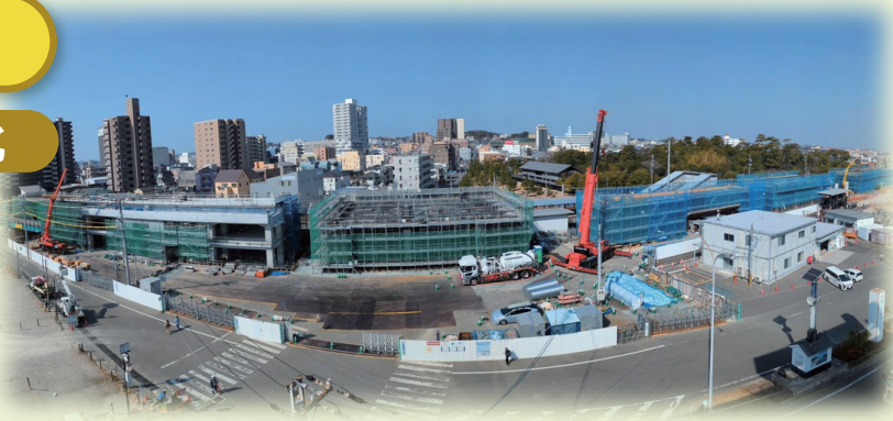
▲JR武豊線高架工事の状況 (JR半田駅前)
