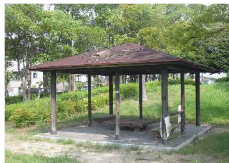
横川公園東屋改修
