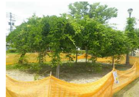
ニツ坂公園パーゴラ設置
