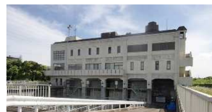
瑞穂排水ポンプ場
