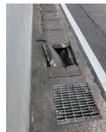
▲側溝の破損
