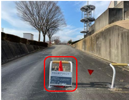
①入口通路 正面
