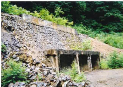
八谷鉱山 旧鉱石積込場（山形県）
