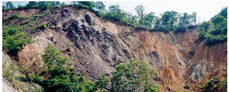
神岡鉱山 丸山ケービング陥没跡（岐阜県）
