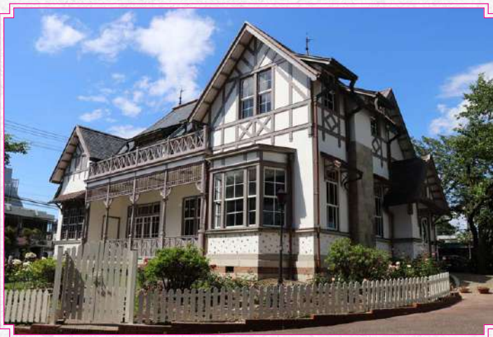
▲重要文化財 旧中埜家住宅
