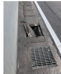
▲側溝の破損
