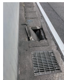
▲側溝の破損
