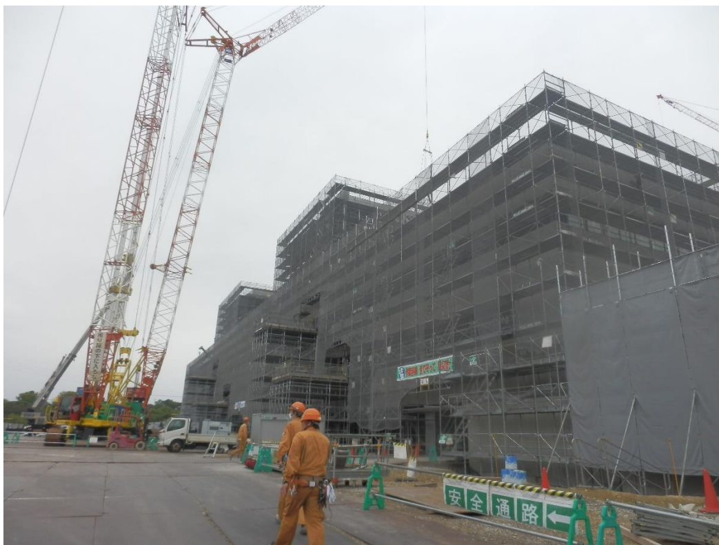
写真 1 : 調査当日の現場外観写真
