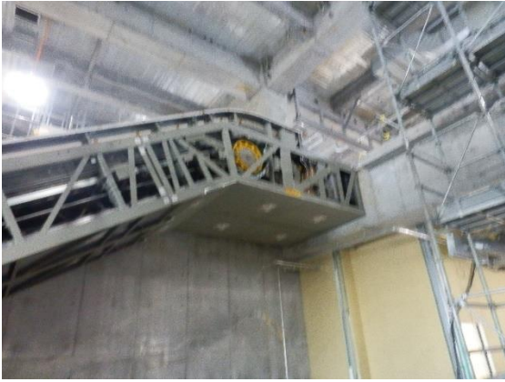
写真 6：エントランスの状況
