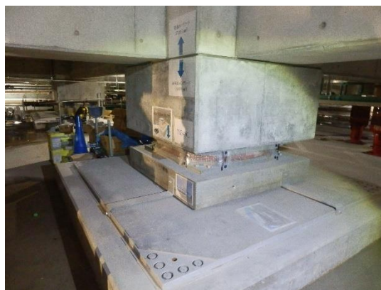
写真 3 : 免震装置設置状況
