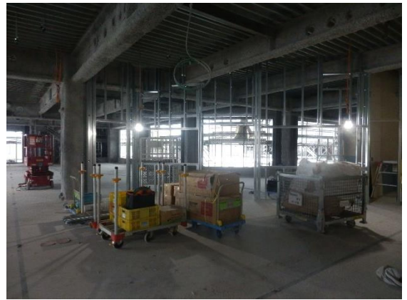
写真 9：内装工事状況
