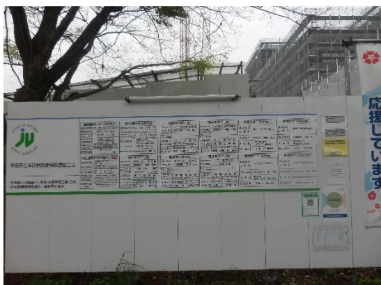
写真 2 : 外部仮囲い掲示状況
