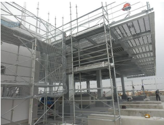
写真 8：ヘリポート工事の状況
