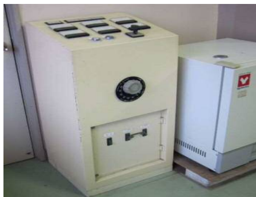
<使用されていない機器>
