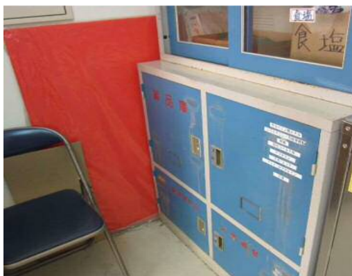
<使用されていない薬品庫>
