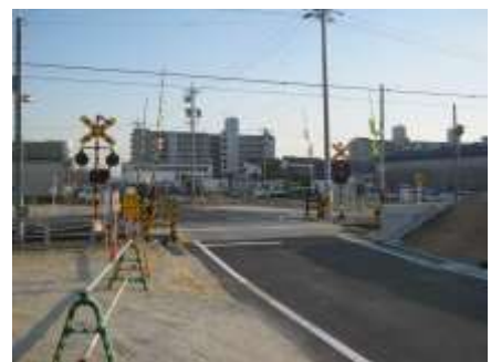
<整備された乙川浜田仮踏切>
