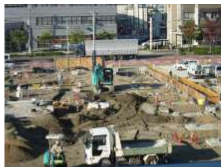
<新庁舎駐車場整備工事の様子>
