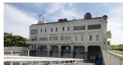
瑞穂排水ポンプ場
