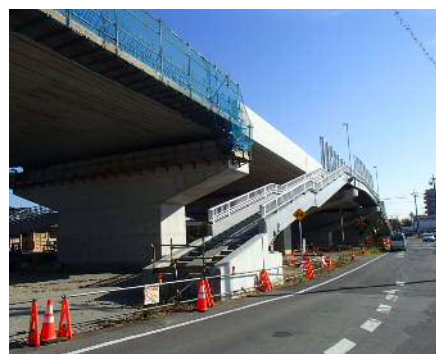
跨線橋整備工事
