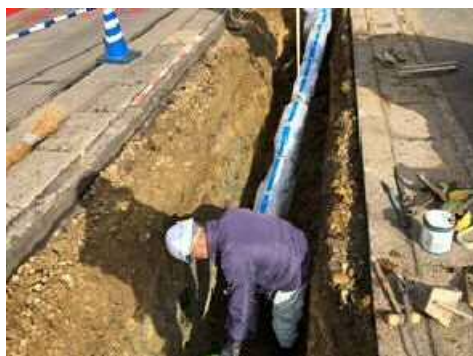
耐震管への布設替 (中ブロックΦ200mm)
