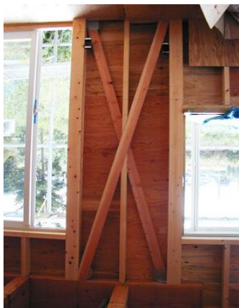
耐震改修事例 (筋違設置)
