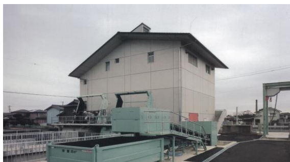
若宮排水ポンプ場（乙川稗田町）
