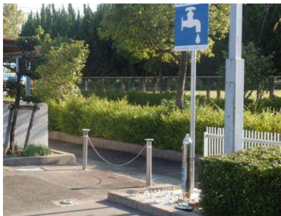
瑞穂記念館に設置した応急給水栓（I29）
