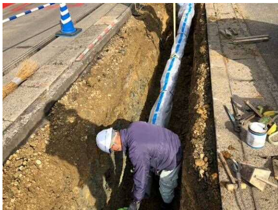
耐震管への布設替 (中ブロック φ200mm)
