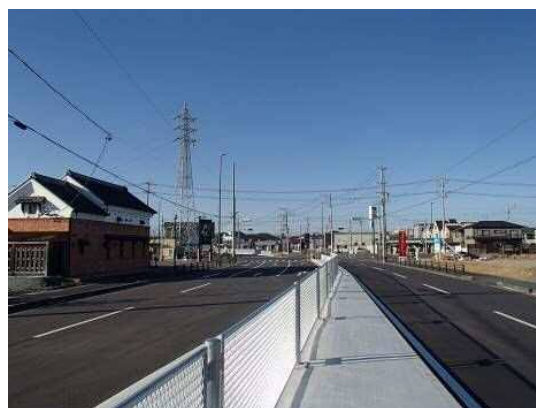
4車線化後の環状線
