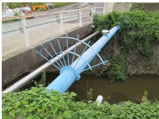
水管橋（石黒町一丁目地内）
