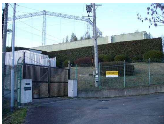
深谷配水池・外観
