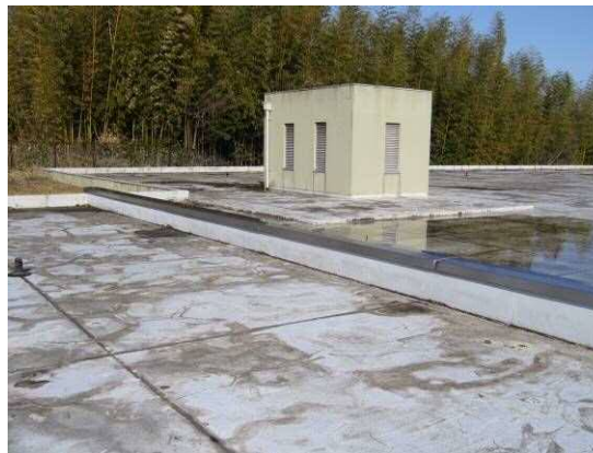
深谷配水池・屋上
