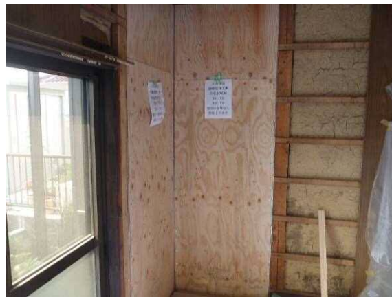
(天井や床を剥がさないで、低コストに行う補強事例)
