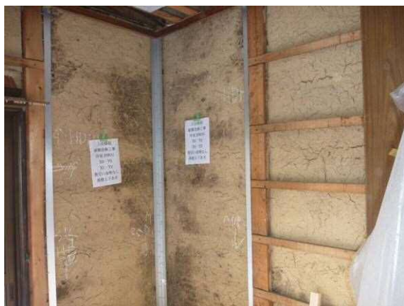
(天井や床を剥がさないで、低コストに行う補強事例)
