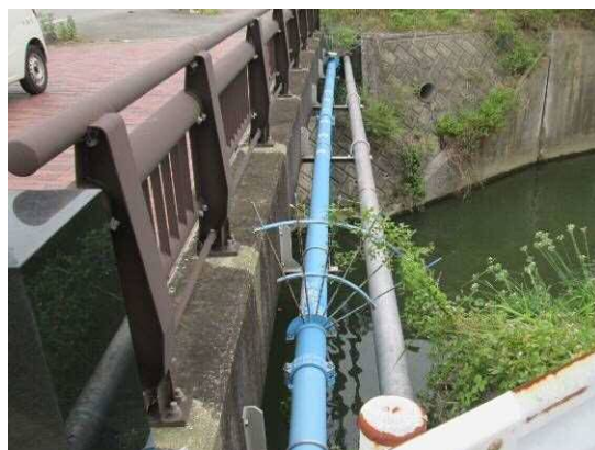
水管橋（板山町十三丁目地内）
