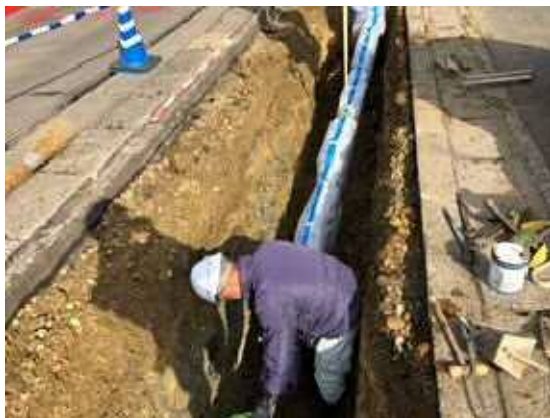
耐震管への布設替 (中ブロックΦ200 mm)
