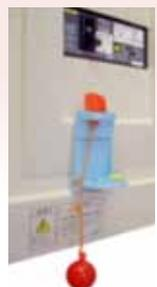
強い揺れにより重りが落下してブレーカーを切ります。
