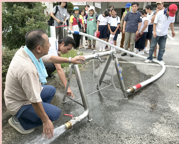
▲応急給水栓から水汲み体験
