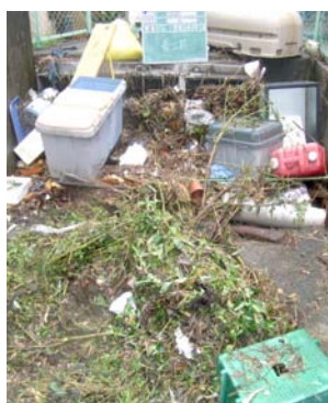
▲道路側溝の詰まり
