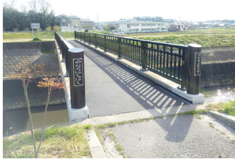
▲今回の改修で綺麗になった橋
