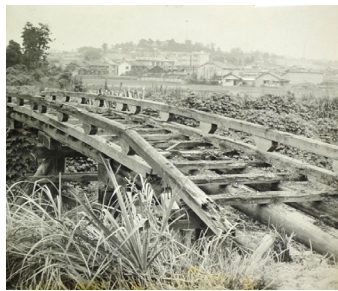
▲昭和53年の鋼桁化前の破損した橋
