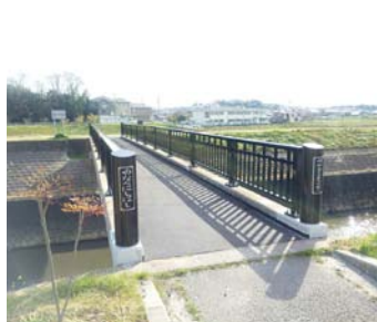
▲今回の改修で綺麗になった橋
