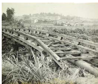
▲昭和53年の鋼桁化前の破損した橋
