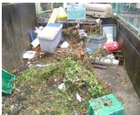
▲水路の詰まり
