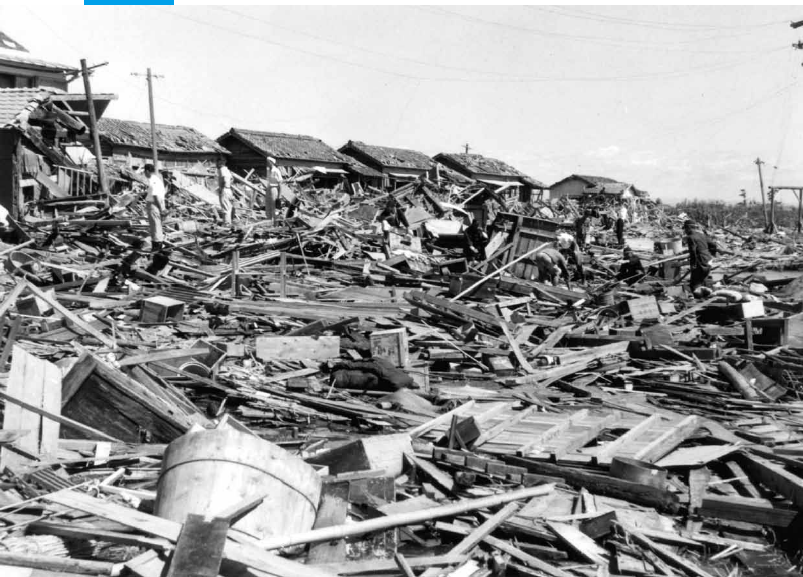
無残に倒壊した建物
