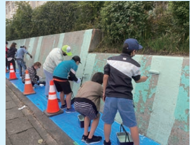
▲ローラーで壁面を塗装
