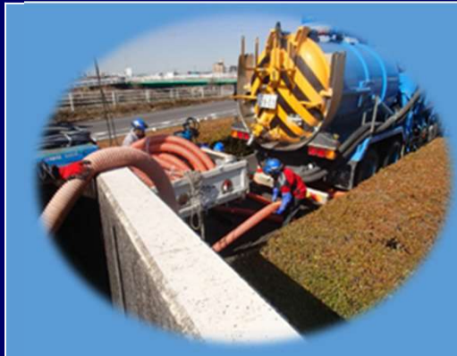
汚水管の清掃の様子
