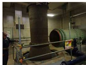
▲ ポンプの引き揚げ作業
