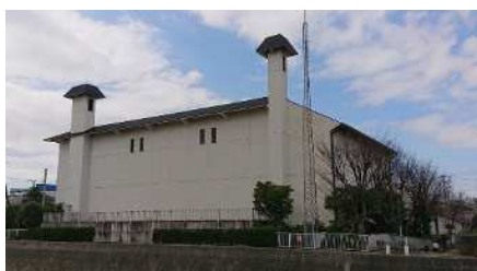
▲ 北浜田排水ポンプ場
