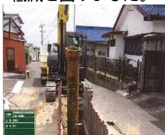
▲ 既設管の撤去
