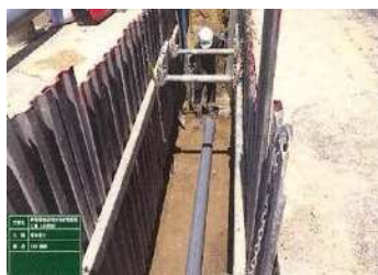
▲ 汚水管の布設替
