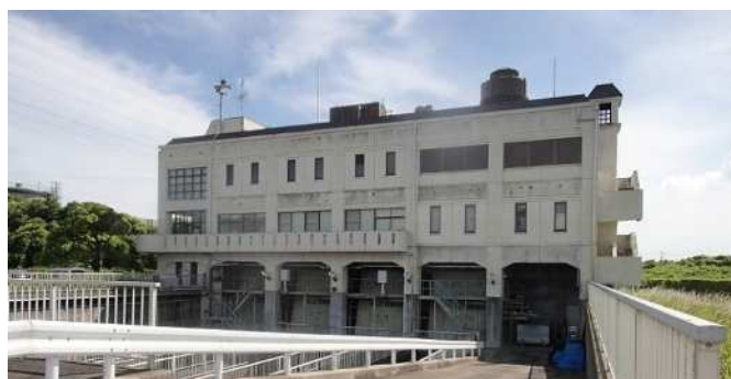
▲瑞穂排水ポンプ場
