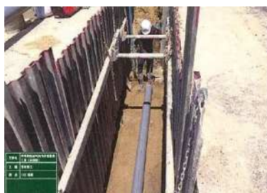
▲ 新設管の埋設
