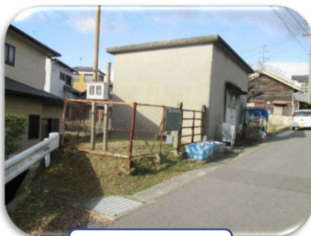
有脇増圧ポンプ場
