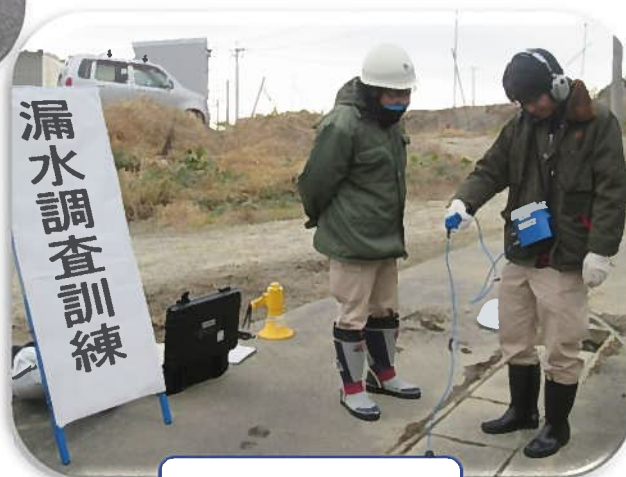
漏水調査訓練
