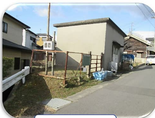
有脇増圧ポンプ場
