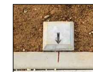
コンクリート杭
